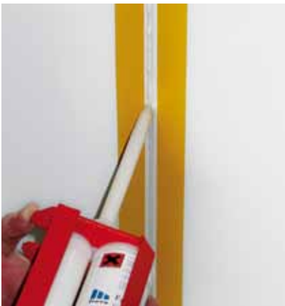
▲ Versiegelung der innenseitigen Fugen mit Freva HygieneTop-Hartverfugung
