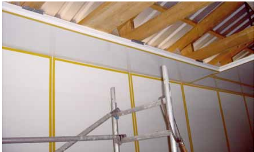
▲ Versiegelung der innenseitigen Fugen mit Freva HygieneTop-Hartverfugung
